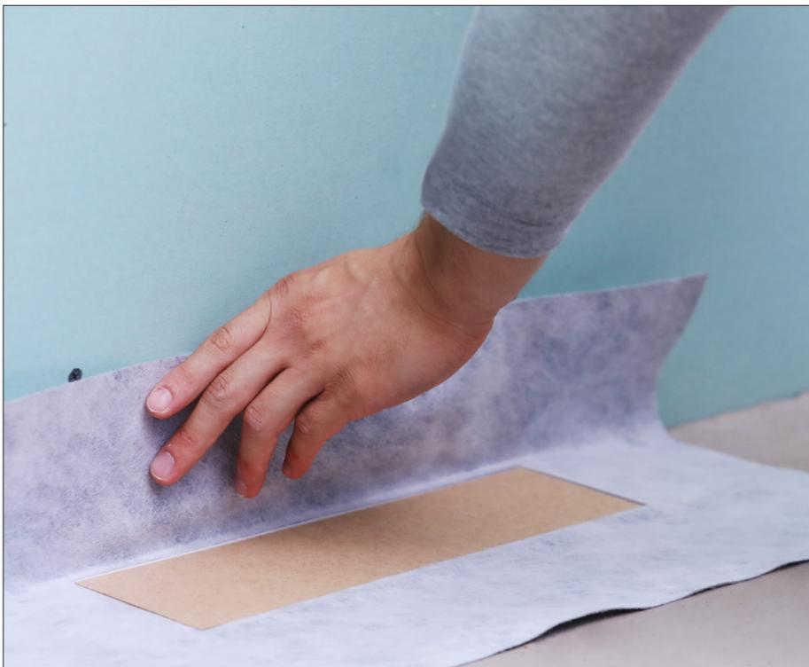
Babero de impermeabilización flexible DallFlex, para el alojamiento de la impermeabilización compuesta y de láminas impermeabilizantes según DIN 18534
